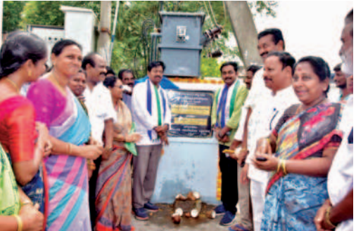
నూరు కెపి ట్రాన్స్ఫార్మర్ను ప్రారంభిస్తున్న ప్రభుత్వవీడి, జగ్గయ్యపేట ఎంఎల్ఎ సామినేని ఉదయభాను.
